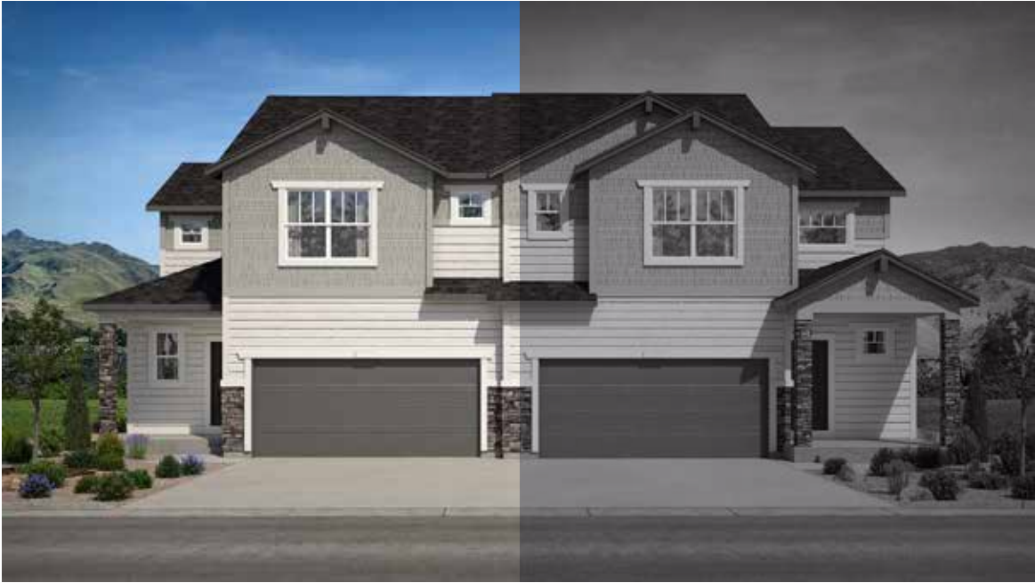
Cottage 3323-A, Unit 2
